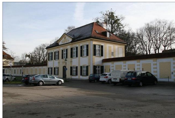
Building of the Carl-Friedrich-von-Siemens-Stiftung
